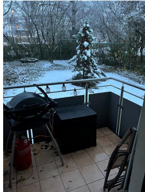
Die Wohnung neigt zu Schimmelbefall
